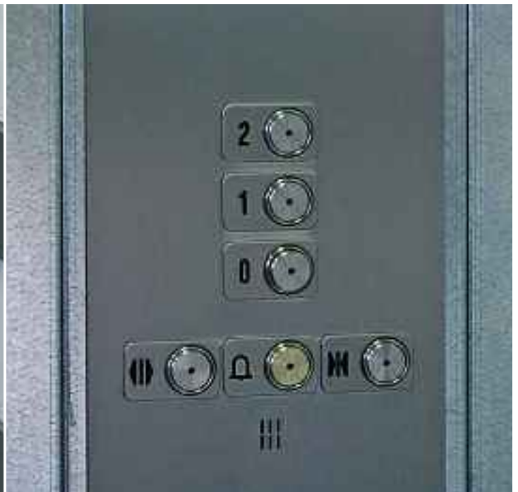
Boîte à boutons cabine en inox, anti-vandalisme.
