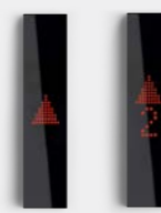
Indicateurs de position et de direction de la cabine d'ascenseur
