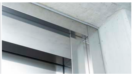
Panneau entre l'encadrement de porte et le mur
