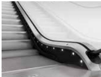
Éclairage de la plinthe avec spots
