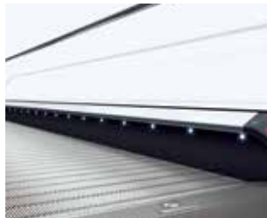
Éclairage des plinthes par spots
