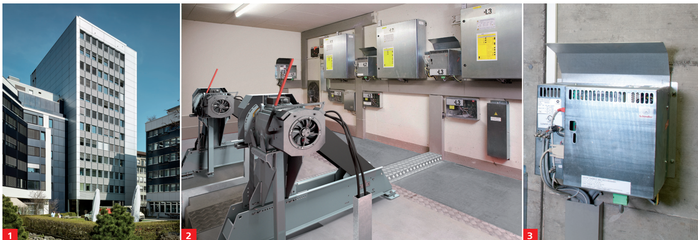
1: Typische gebouwtoepassing | 2: Machinekamer | 3: Omvormer met energierugwinning
